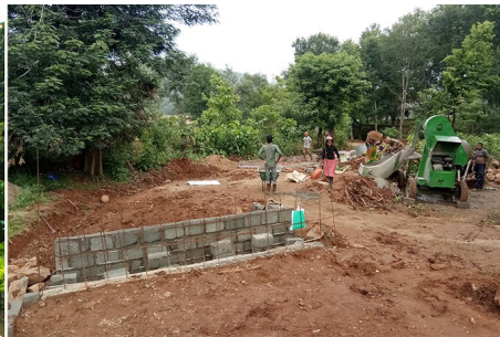
Ausbau der Zufahrtsstrasse
